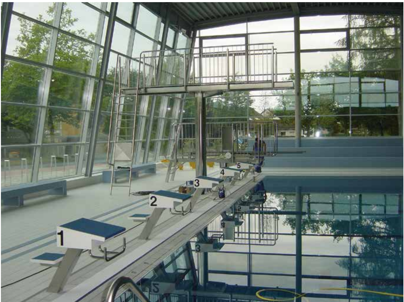
Bild 8: Sicherer Schwimmbadbetrieb: Die gesamte Konstruktion des Sprungturms in einem Hallenbad besteht aus Edelstahl Rostfrei
