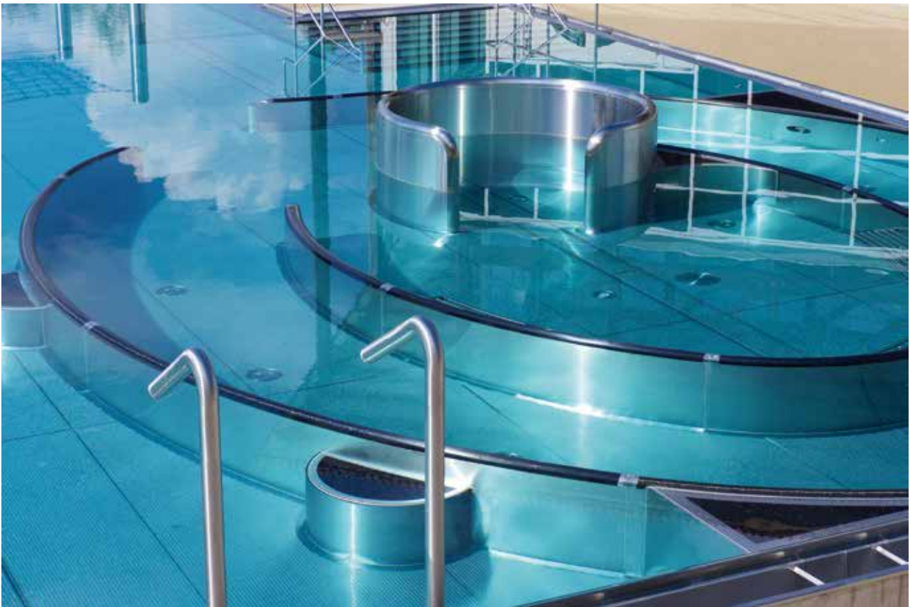
Bild 6: Die guten Umformeigenschaften ermöglichen vielfältige Einsatzmöglichkeiten mit Edelstahl Rostfrei in Schwimmbädern
