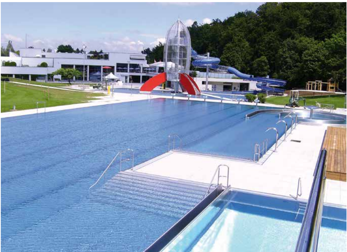
Bild 9: Die glatte Oberflächenausführung des Werkstoffs ist korrosionsbeständig, leicht zu reinigen und dadurch wartungsarm und langlebig
