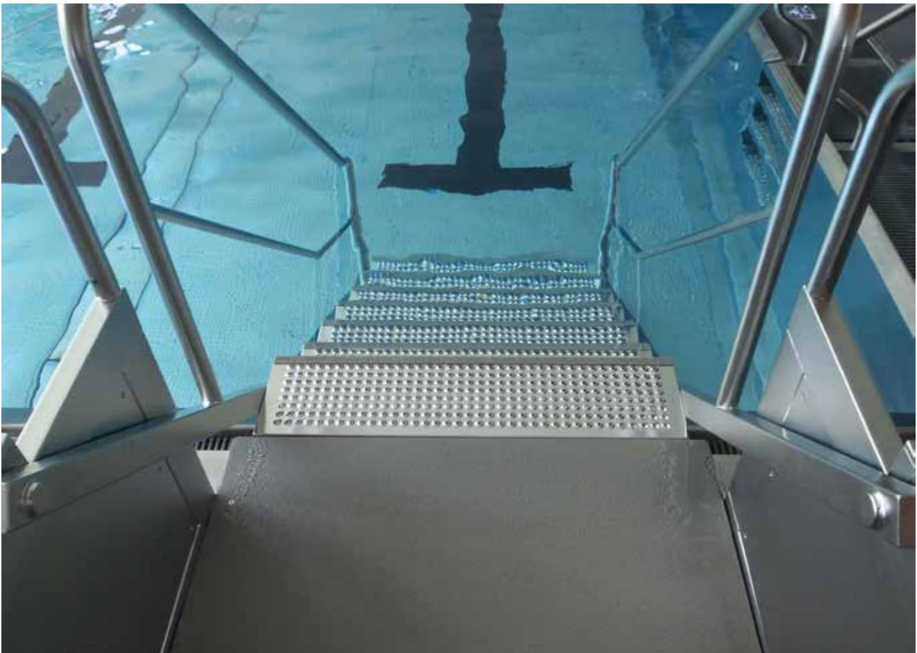
Bild 2: Eine mobile Schwimmbadterrasse ganz aus Edelstahl Rostfrei ist absolut hygienisch und erfüllt höchste Ansprüche an Sicherheit und Design
