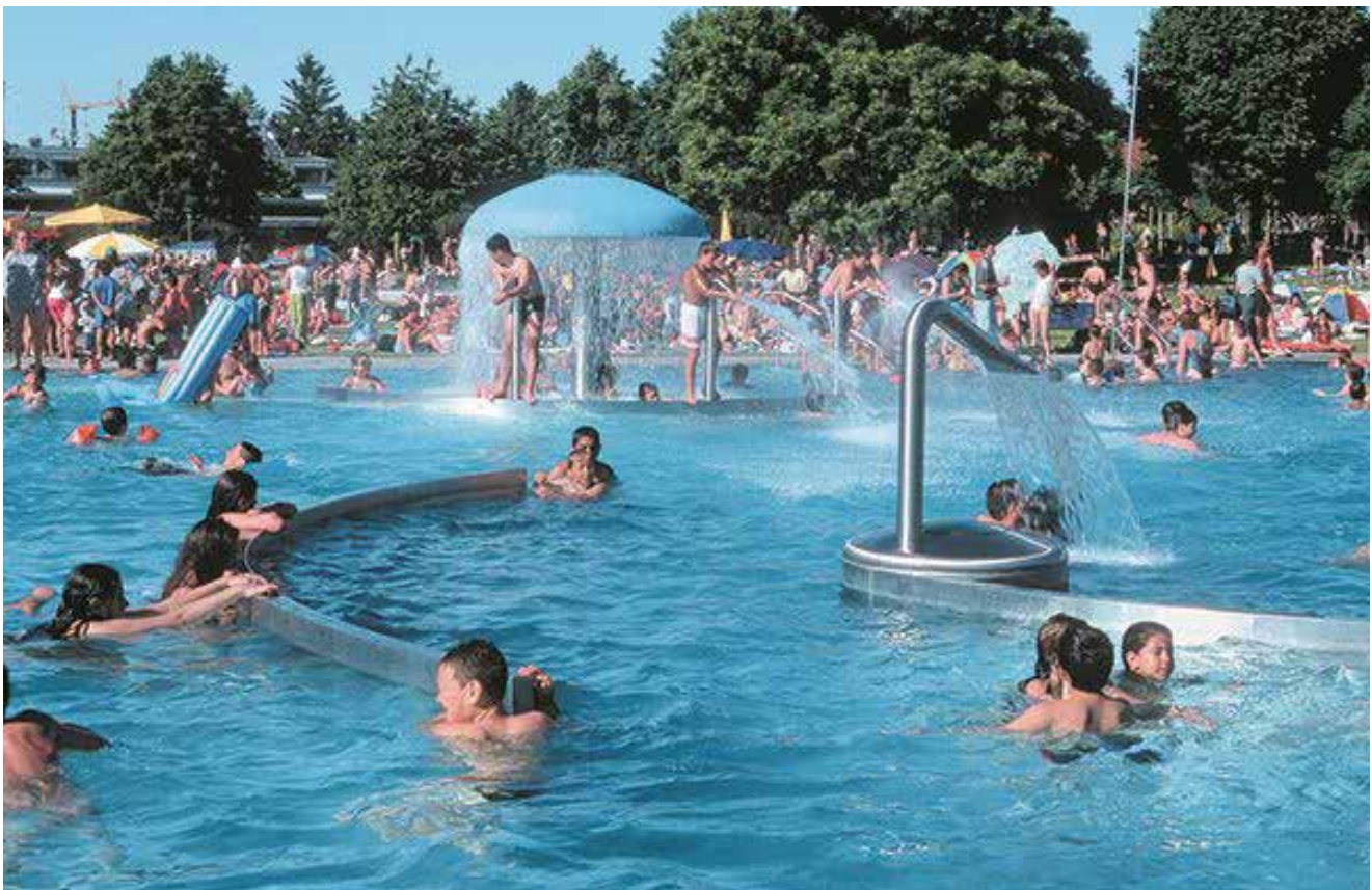
Bild 1: Im Erlebnisbecken ist Edelstahl Rostfrei ein Material für alle Einsatzzwecke
